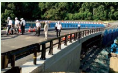
新高苑につながる橋梁が開通しました。
